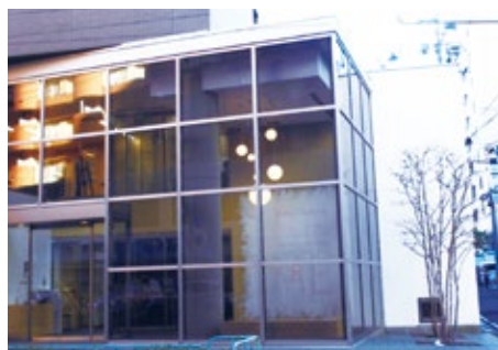
東北オフィスのエントランス
