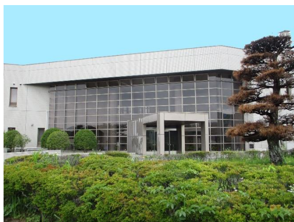
広瀬川管理事務所がある広瀬川浄化センター
